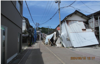
半壊した家屋で道路が半分塞がれたまま（珠洲市）
