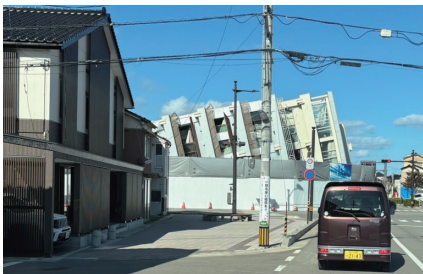
倒壊したままの建物
